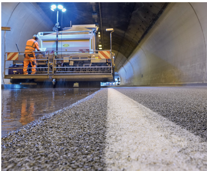
Bild 1: Auftrag des Reaktionsharzes
