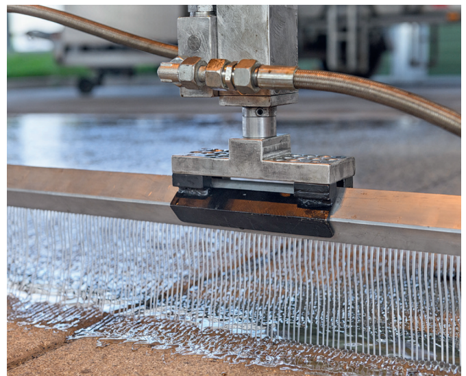
Bild 2: Druckloser Auftrag des Reaktionsharzes im Gießverfahren
