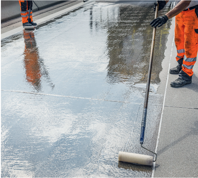
Bild 3: Herstellen eines definierten Randabschlusses der Beschichtungsfläche
