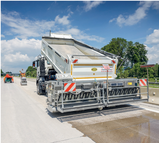
Bild 4: Aufgabe der Abstreuerung aus dem LKW
