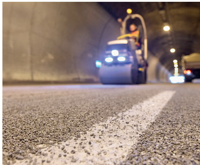
Bild 6: Abstreuerung mit Andrückwalze im Hintergrund
