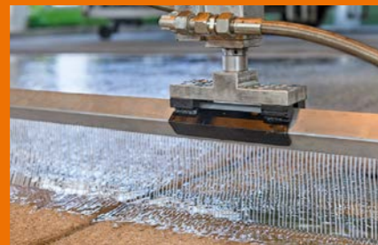
Druckloser Auftrag des Reaktionsharzes
