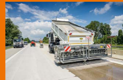
Abstreuung mittels Walzenstreuer
