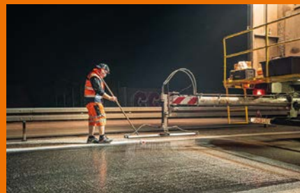
Auftrag des Reaktionsharzes
