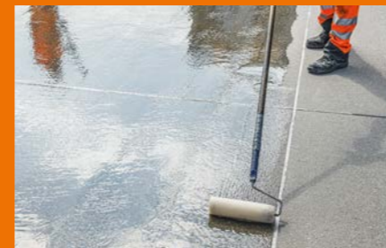
Herstellen des definierten Randabschlusses
